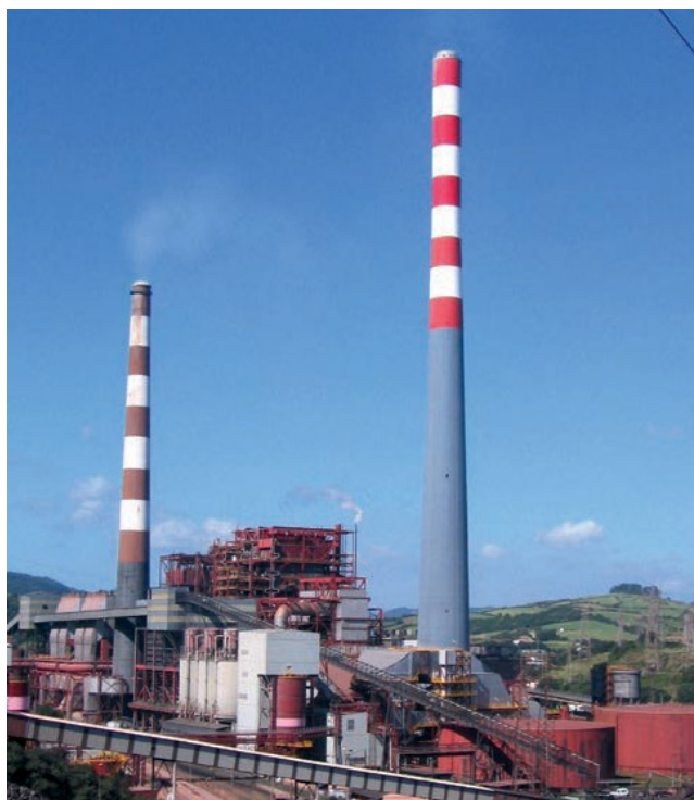
Powlekany komin elektrowni
