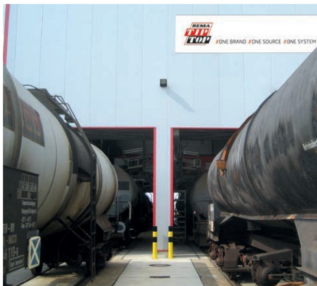
Centrum zbiorników kolejowych w Wittenberdze
