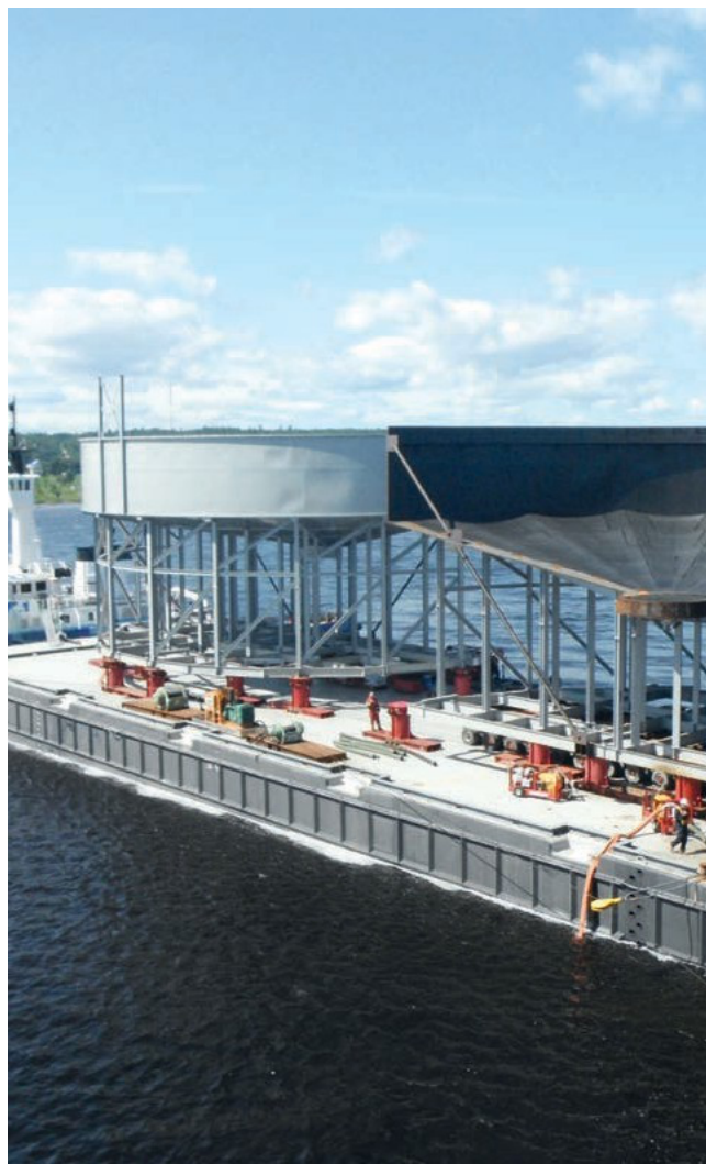
Dostawa części zagęszczacza wyłożonych gumą
