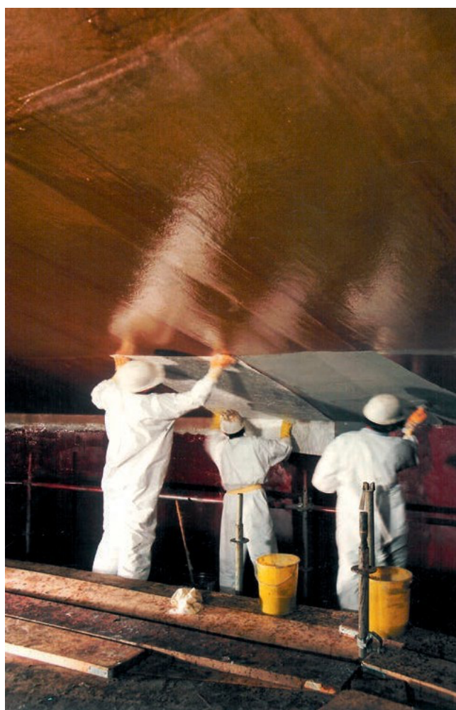
Montaż powłoki laminowanej
