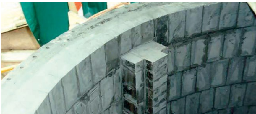
Zbiornik wyłożony cegłami węglowymi i CHEMOKITT FU 1320
