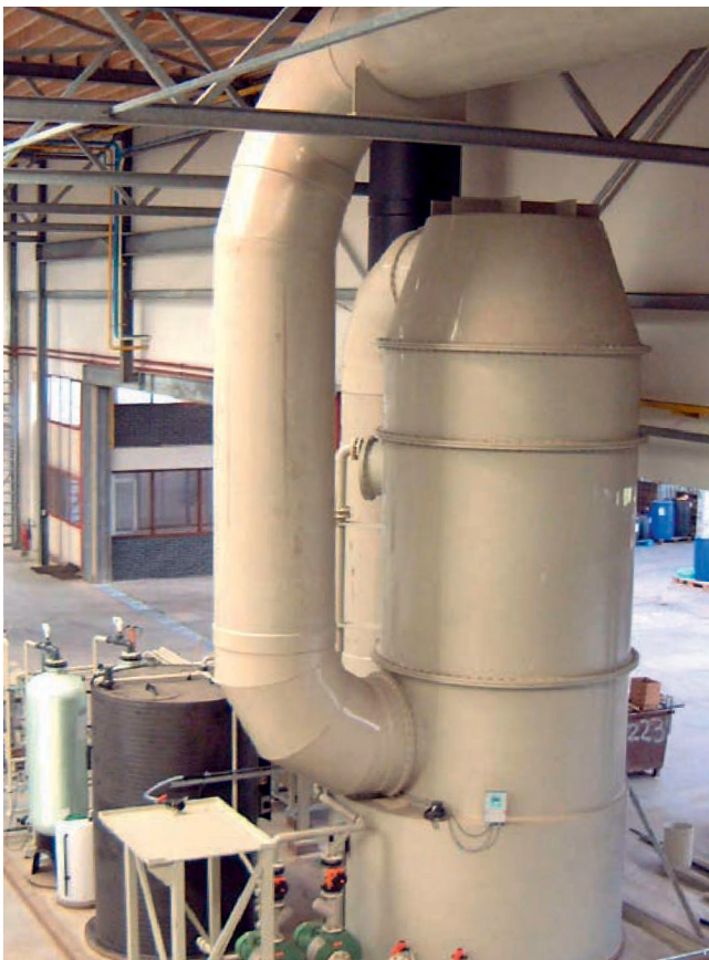
Płuczka powietrza odlotowego w PP
