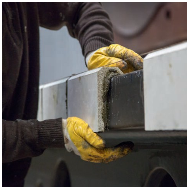
Praca z zaprawą z żywicy syntetycznej
