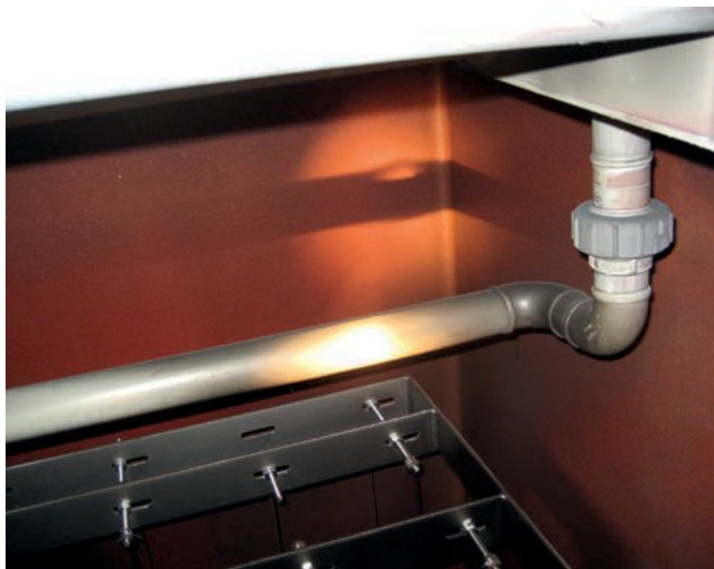
Powłoka COROFLAKE w mokrym ESP
