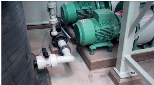
Cegły polibetonowe jako fundament urządzeń pompujących
